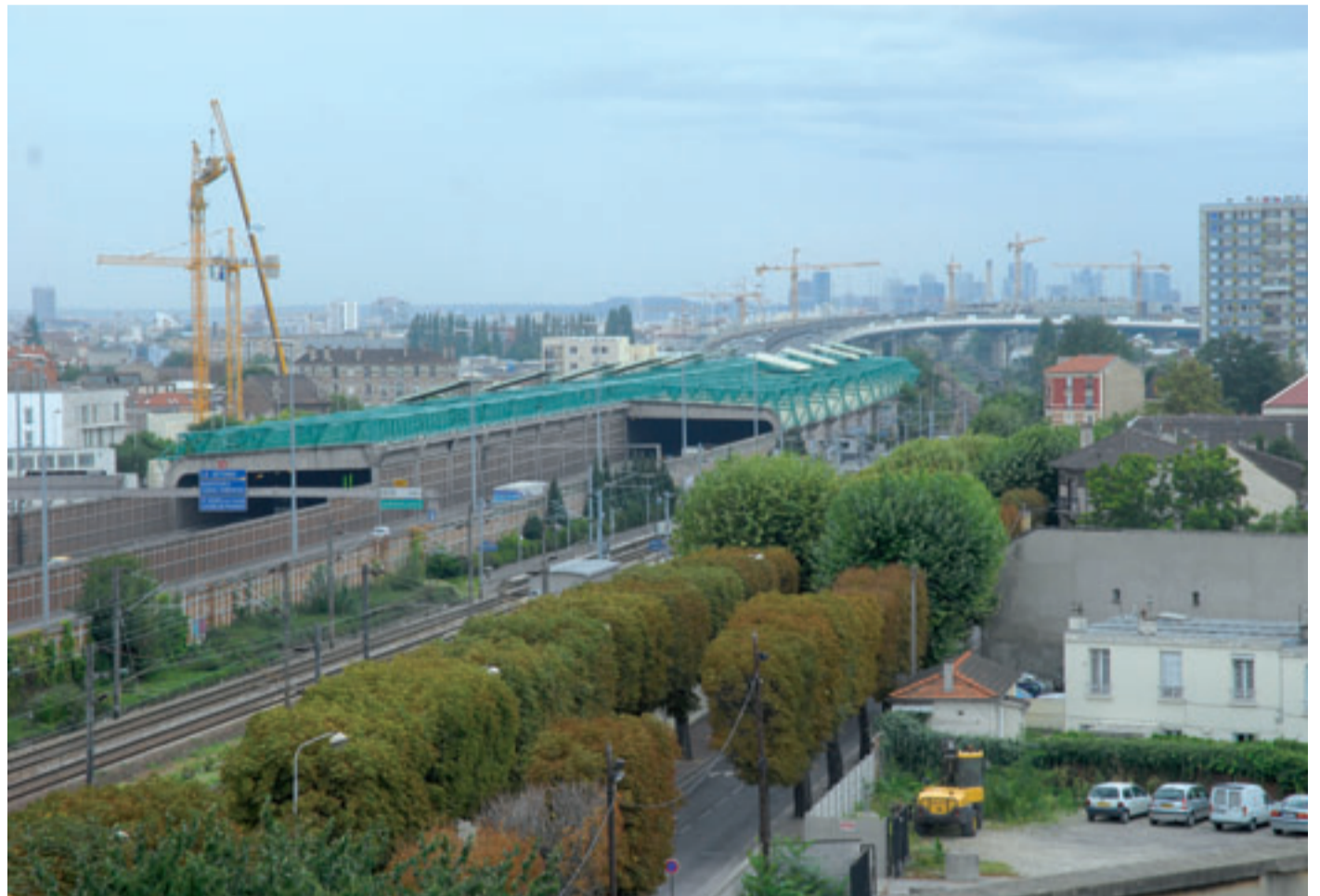
Autoroute A1, A86, gare RER... l'État doit tenir ses engagements !
